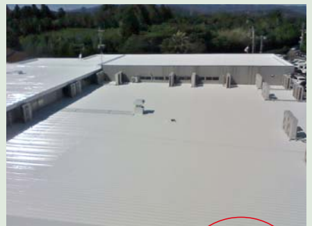
●施工後(9/26 14:00頃撮影)
