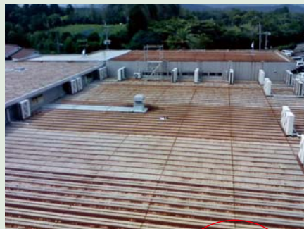
●施工前(8/12 14:00頃撮影)
